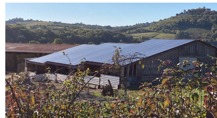
Vézelay – panneaux photovoltaïques sur toiture. ©Jean-François Briand (ABF - Drac BFC)
