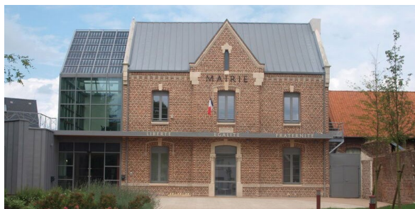
Construction photovoltaïque rattachée, mairie de Raillencourt-Sainte-Olle. © Mairie de Raillencourt
